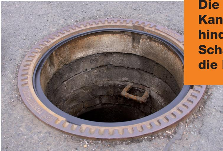
**Die dämpfende Einlage im Kanalschachtrahmen verhindert das Klappern der Schachtdeckel und schützt die Deckelauflagefläche!**
